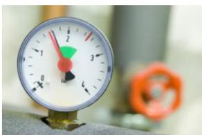
Se la lancetta è sotto l'1 è necessario aprire il rubinetto dell'acqua (di colore blu o nero) posto generalmente sotto la caldaia, controllare contemporaneamente il manometro e chiudere **bene** il rubinetto non appena la lancetta sarà nella posizione indicata
