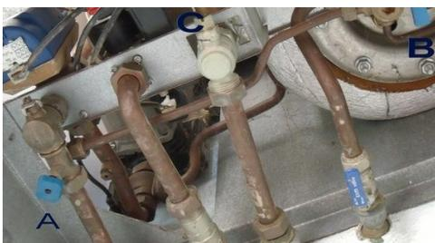
Spesso capita che il rubinetto non viene chiuso correttamente e la caldaia inizia a buttare l'acqua, il manometro sarà sicuramente posizionato sopra il due e sarà necessario perciò togliere acqua dalla valvola di sfogo di un termosifone tenendo sempre d'occhio il manometro.
